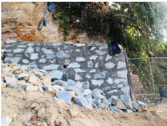
De steunmuur van onderaf
