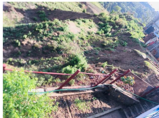
De steunmuur van bovenaf
