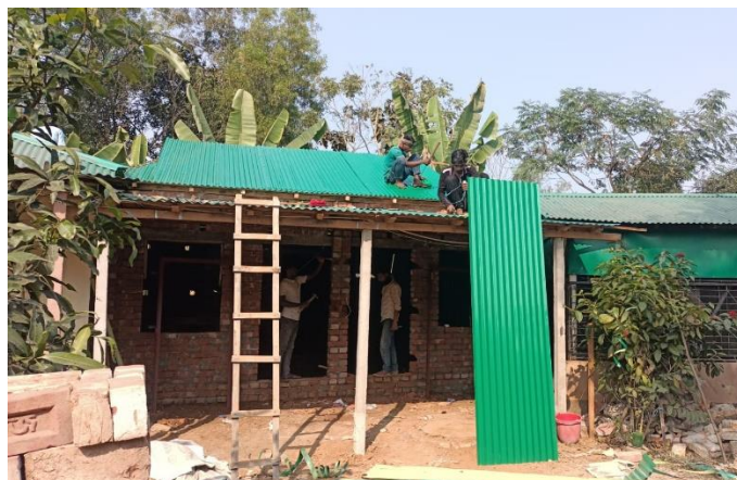
Het extra klaslokaal in aanbouw
