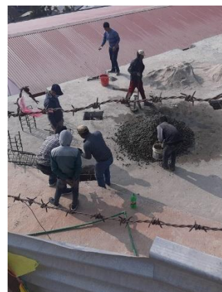
Start bouw Activiteitenhal
