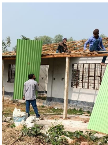
Nieuw centrum in aanbouw
